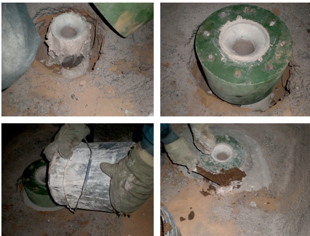
Рис. 4. Порядок монтажа и фиксации кольцевого продувочного блока в днище промежуточного ковша слябовой МНЛЗ АМК
