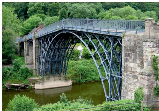
**Рис. 2.** Первый чугунный мост, построенный в 1779 г. в Англии через реку Северн
